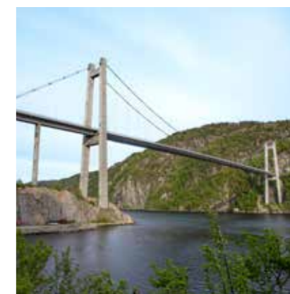
FEDAFJORDEN BRU ER EN HENGEBRO OVER FEDAFJORDEN I KVINESDAL KOMMUNE. DEN ER 566 M LANG OG HAR ET HOVEDSPENN PÅ 331 M OG 50 METER SEILINGSHØYDE.
